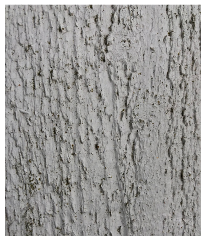
Clas Ohlson (31) Alnarp. Alg- och mögelpåväxt.
