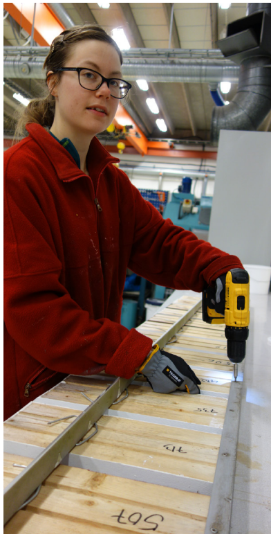
Demontering av paneler.
