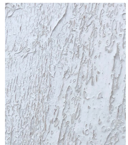
Teknos Tranemo äkta linoljefärg (44) Vindeln. Krackelering.
